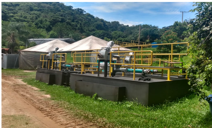
Foto 8- Montagem de equipamento e sistemas. 09/2022
