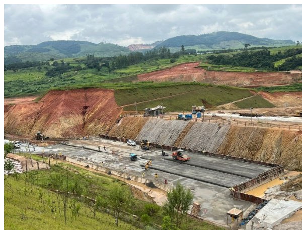
Foto 13: Atividades de concretagem na Ogiva (23/01/2023)
