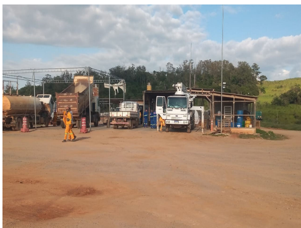
Foto 3: Manutenção Mecânica de apoio no canteiro operacional (22/12/2022)
