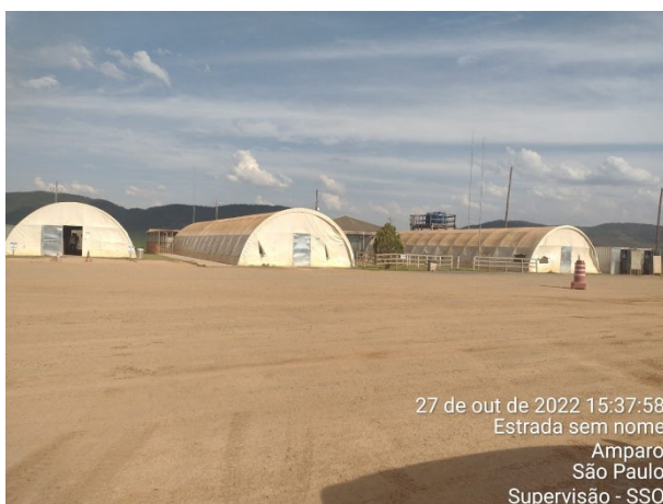
Foto 1: Escritório - canteiro operacional (27/10/2022)
