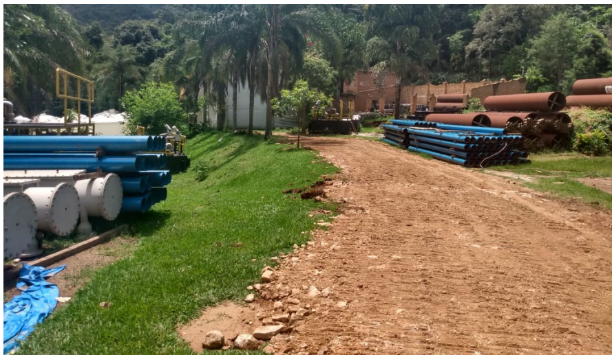
Foto 7-Montagem de equipamentos e sistemas- rodas de dragagem. 01/2023
