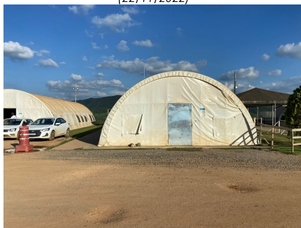
Foto 4: Refeitório canteiro operacional (24/01/2023)
