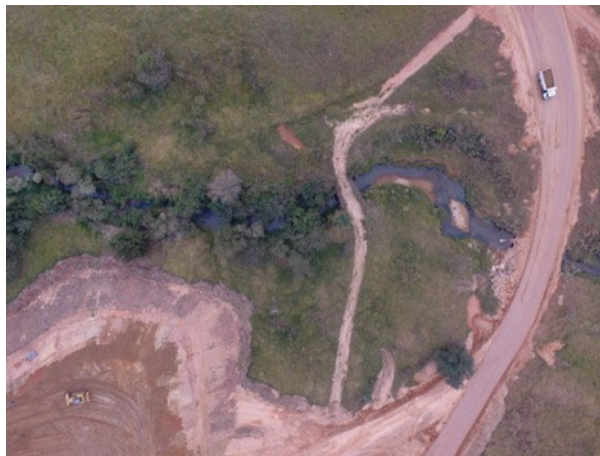
Foto 16: Acesso sob o Ribeirão Pantaleão - (16/07/2021)
