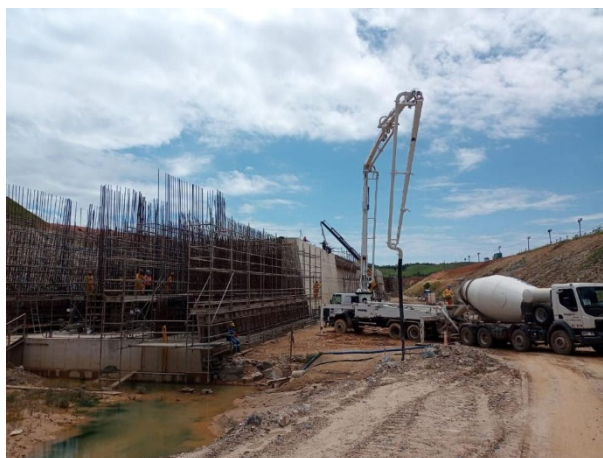
Foto 12: Concretagem na galeria de desvio. (14/12/2022)
