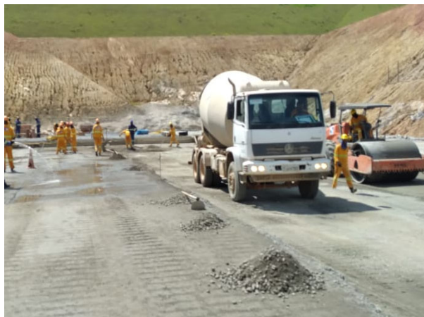
Foto 10: Vista Atividades de concretagem na Ogiva (28/10/2022)
